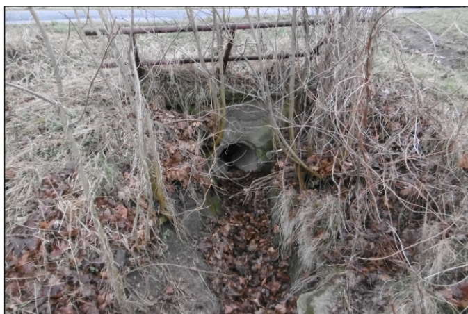
Propustek 54c - staničení 1,489 - pohled zprava
