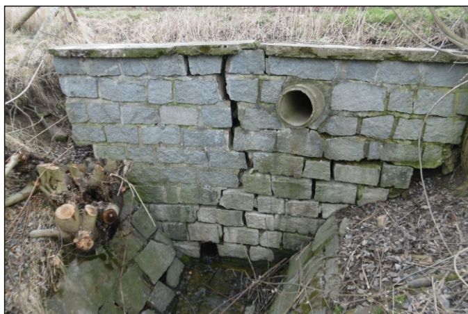
Propustek 80c - staničení 1,140 - pohled zleva
