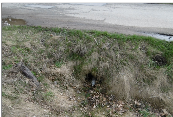
Propustek 44c - staničení 1,342 - pohled zprava
