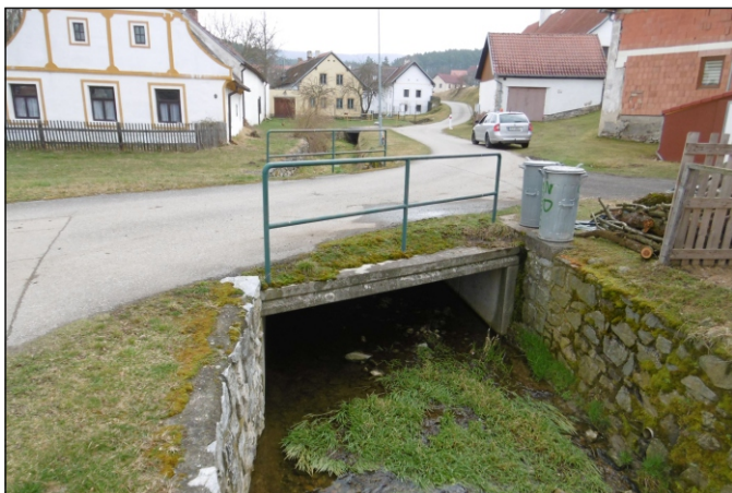
Most 78c-M1 - staničení 0,049 - pohled zprava
