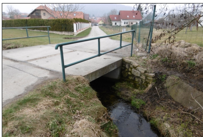
Propustek 55c - staničení 0,220 - pohled zleva
