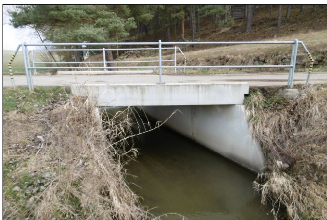
Most 75c-M1 - staničení 0,380 - pohled zleva
