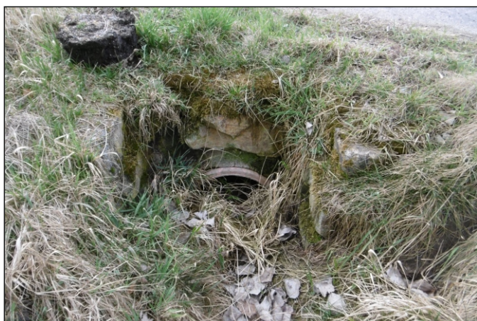
Propustek 43c - staničení 0,001 - pohled zleva
