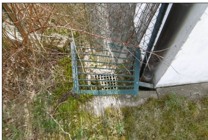
Propustek 81c - staničení 0,031 - pohled zprava
