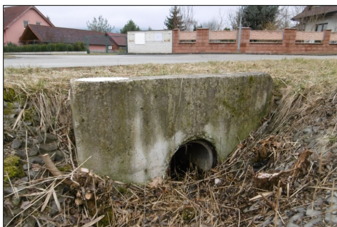
Propustek 2c - staničení 0,420 - pohled zprava
