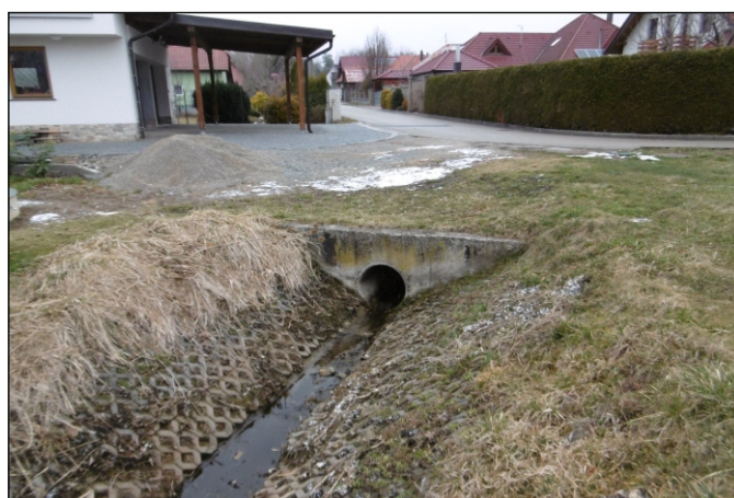
Propustek 2c - staničení 0,173 - pohled zprava
