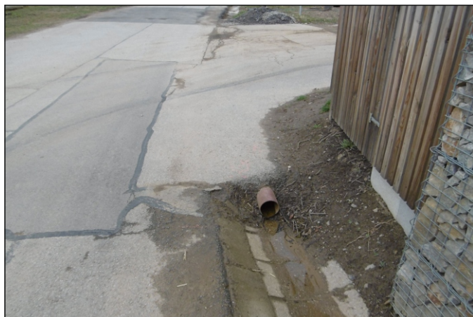
Propustek 52c - staničení 0,001 - pohled zprava
