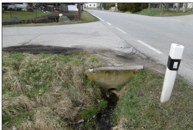
Propustek 85c - staničení 0,001 - pohled zleva
