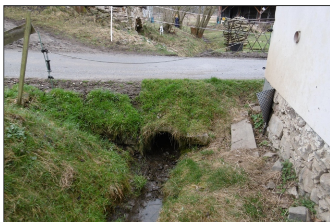
Propustek 65c - staničení 1,217 - pohled zleva
