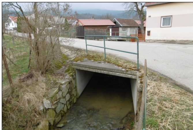
Most 45c-M1 - staničení 0,267 - pohled zleva
