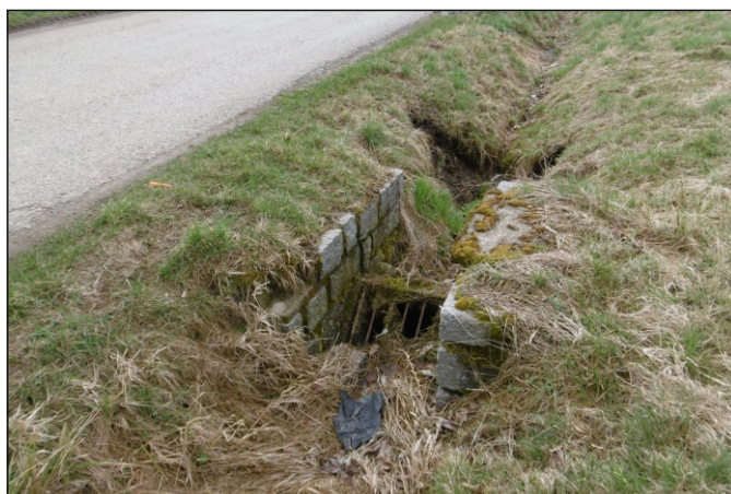
Propustek 44c - staničení 0,952 - pohled zprava
