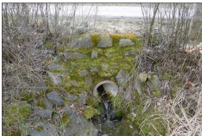
Propustek 79c - staničení 0,079 - pohled zleva
