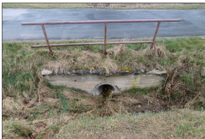
Propustek 54c - staničení 1,489 - pohled zleva
