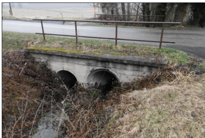
Propustek 54c - staničení 1,862 - pohled zleva
