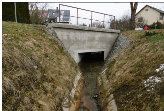
Propustek 1c - staničení 0,124 - pohled zleva
