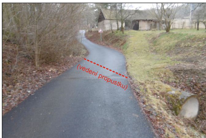
Propustek 62c - staničení 0,053 - celkový pohled
