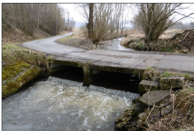
Propustek 65c - staničení 1,028 - pohled zprava
