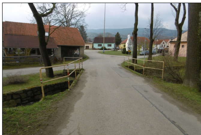
Most 44c-M1 - staničení 0,167 - celkový pohled
