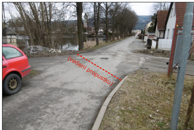
Propustek 12c - staničení 0,205 - celkový pohled
