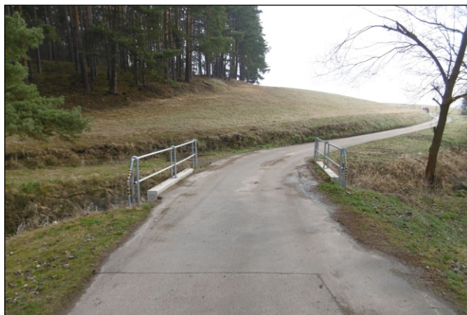
Most 75c-M1 - staničení 0,380 - celkový pohled
