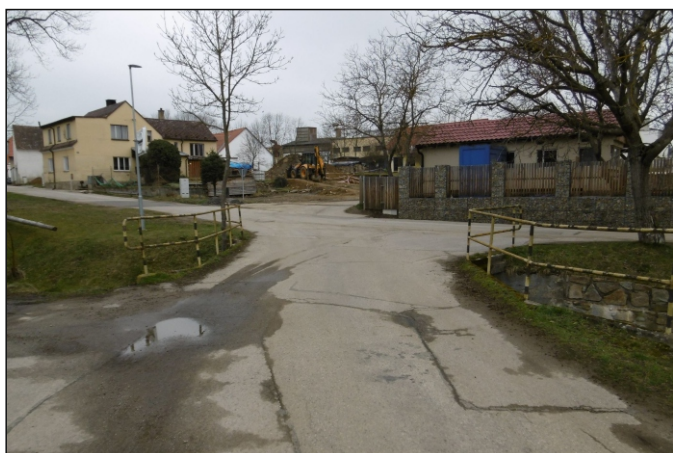
Most 46c-M1 - staničení 0,110 - celkový pohled
