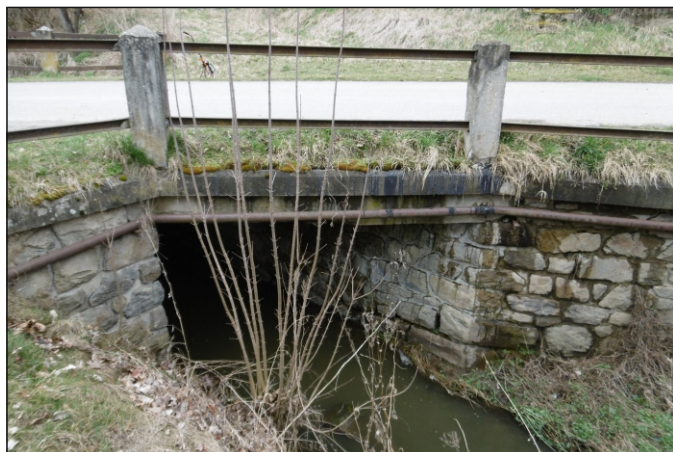
Most 67c-M1 - staničení 2,087 - pohled zprava
