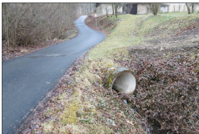
Propustek 62c - staničení 0,053 - pohled zprava
