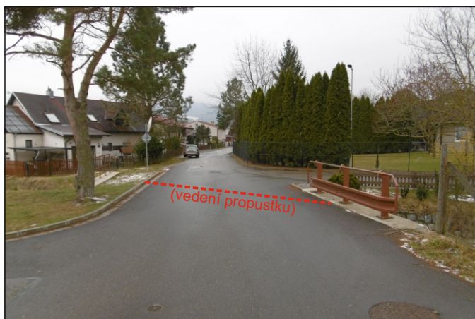
Propustek 1c - staničení 0,124 - celkový pohled
