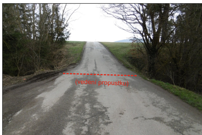
Propustek 44c - staničení 1,317 - celkový pohled
