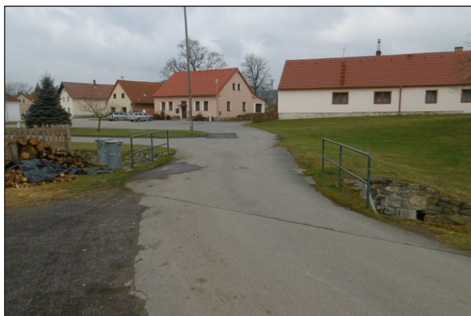
Most 78c-M1 - staničení 0,049 - celkový pohled
