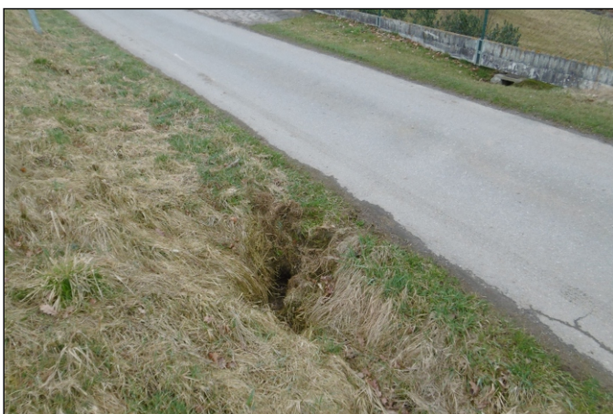
Propustek 78c - staničení 0,195 - pohled zprava
