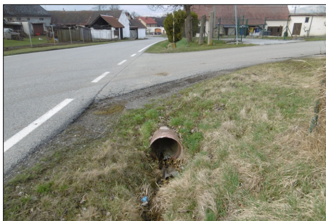
Propustek 82c (rameno) - staničení 0,050 - pohled zleva
