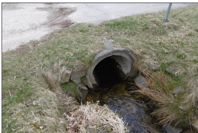
Propustek 53c - staničení 0,140 - pohled zleva
