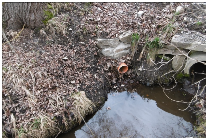
Propustek 12c - staničení 0,198 - pohled zprava
