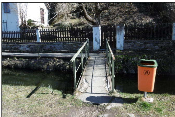
Lávka 44d-L2 - staničení 0,073 - celkový pohled
