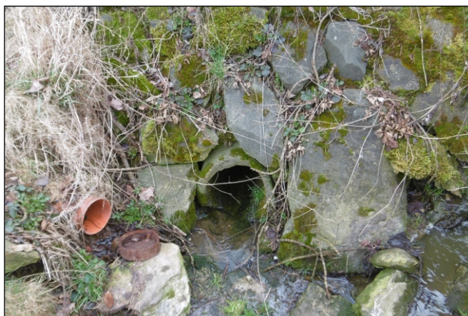
Propustek 79cc - staničení 0,083 - pohled zleva
