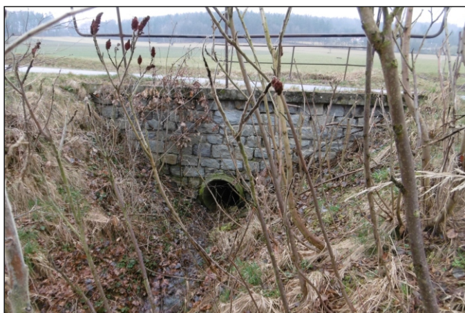
Propustek 54c - staničení 1,334 - pohled zprava
