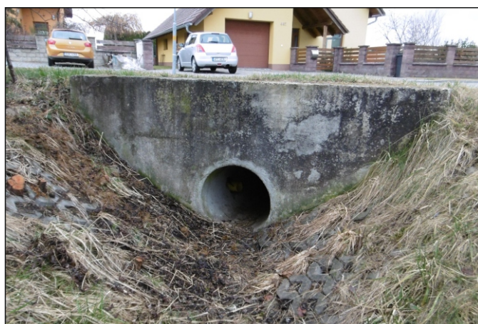
Propustek 3c - staničení 0,002 - pohled zleva
