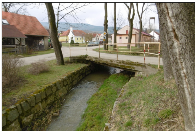
Most 44c-M1 - staničení 0,167 - pohled zleva
