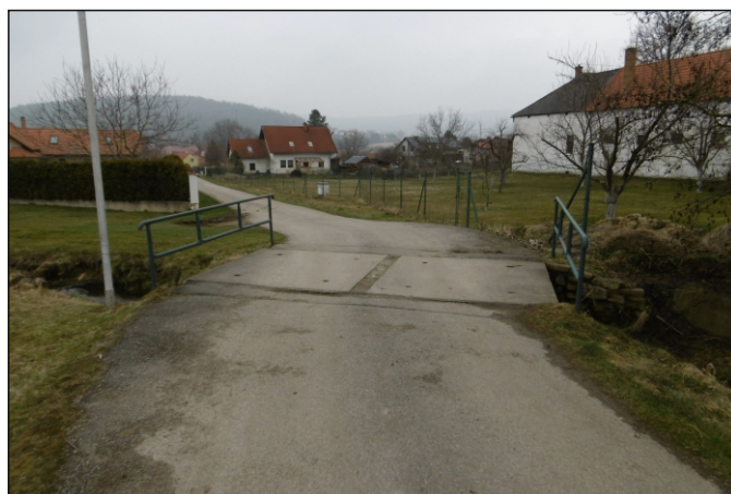
Propustek 55c - staničení 0,220 - celkový pohled
