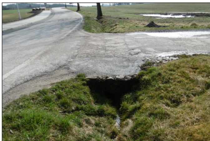
Propustek 22c - staničení 0,002 - pohled zprava
