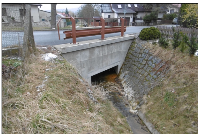
Propustek 1c - staničení 0,124 - pohled zprava
