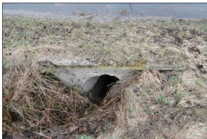
Propustek 54c - staničení 0,364 - pohled zleva
