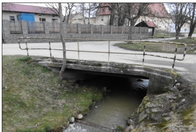
Most 46c-M1 - staničení 0,110 - pohled zleva
