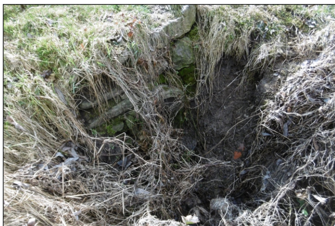
Propustek 81c - staničení 0,031 - pohled zleva
