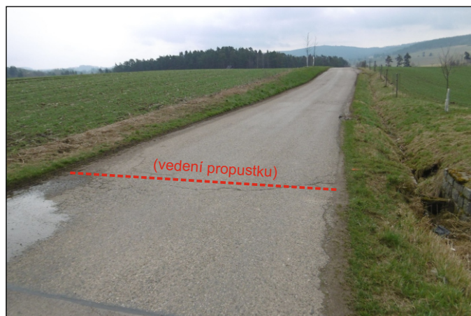
Propustek 44c - staničení 0,952 - celkový pohled
