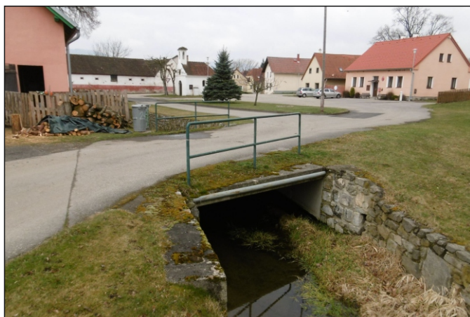
Most 78c-M1 - staničení 0,049 - pohled zleva
