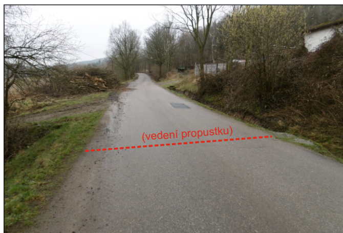
Propustek 54c - staničení 2,298 - celkový pohled
