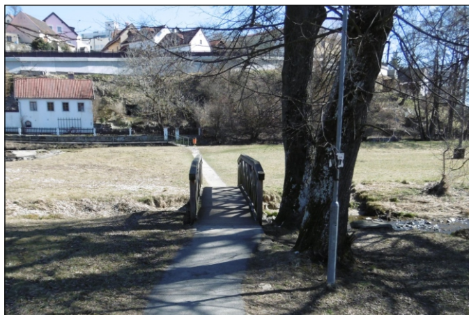
Lávka 44d-L1 - staničení 0,024 - celkový pohled
