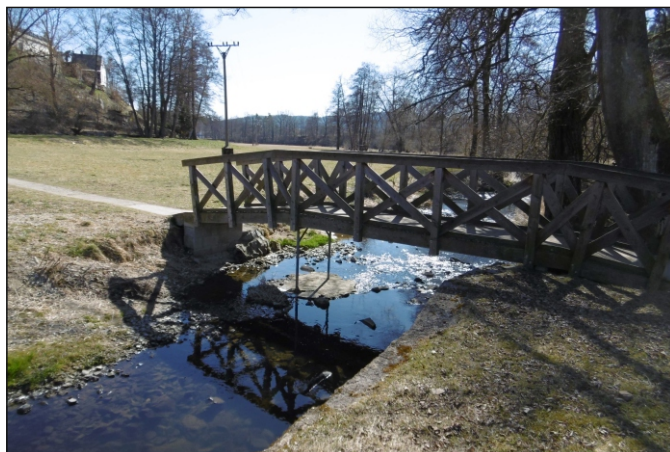
Lávka 44d-L1 - staničení 0,024 - pohled zleva
