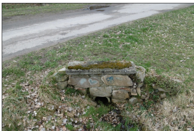
Propustek 67c - staničení 2,014 - pohled zprava
