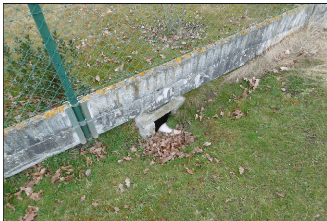
Propustek 78c - staničení 0,195 - pohled zleva
