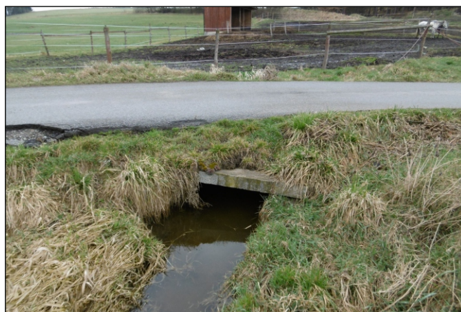
Propustek 65c - staničení 1,147 - pohled zprava
