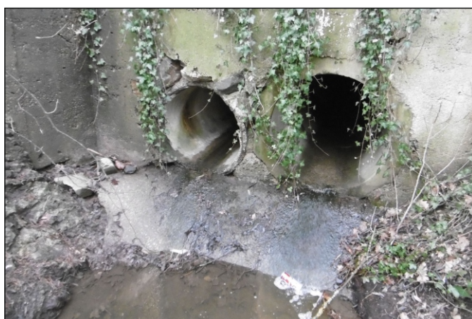
Propustek 44c - staničení 1,317 - pohled zleva
