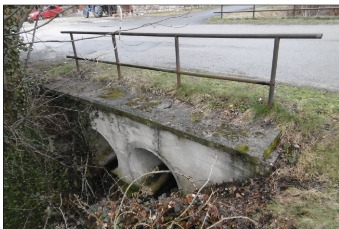
Propustek 54c - staničení 1,862 - pohled zprava
