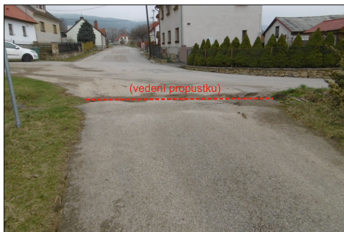
Propustek 53c - staničení 0,140 - celkový pohled
