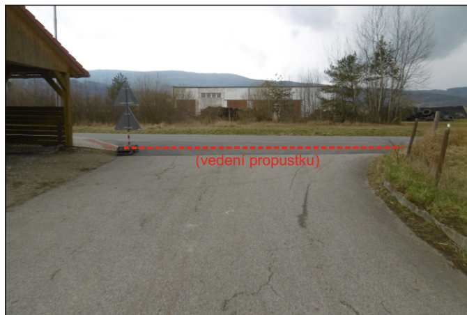
Propustek 43c - staničení 0,001 - celkový pohled
