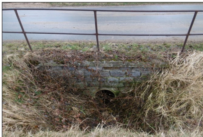
Propustek 54c - staničení 1,334 - pohled zleva
