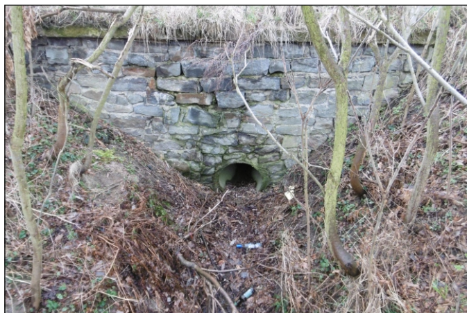
Propustek 54c - staničení 1,086 - pohled zprava
