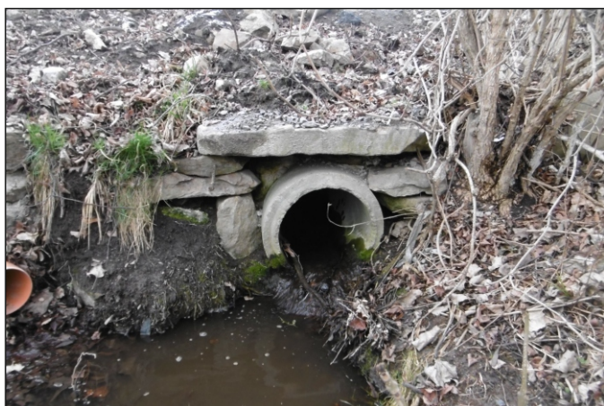
Propustek 12c - staničení 0,205 - pohled zprava
