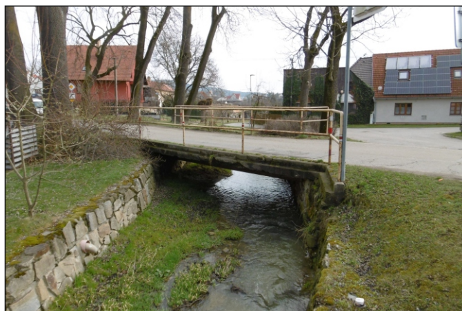
Most 44c-M1 - staničení 0,167 - pohled zprava
