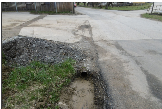
Propustek 52c - staničení 0,001 - pohled zleva
