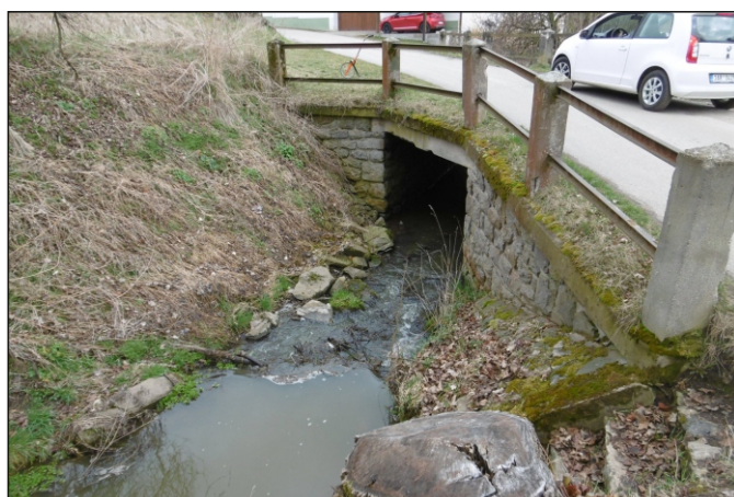
Most 67c-M1 - staničení 2,087 - pohled zleva
