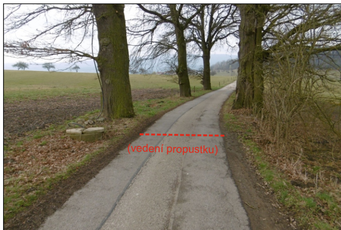
Propustek 80c - staničení 0,248 - celkový pohled
