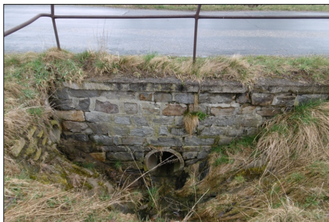
Propustek 54c - staničení 1,086 - pohled zleva
