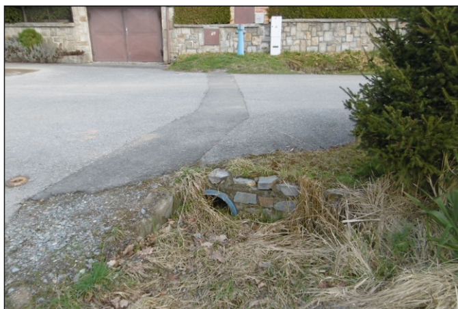
Propustek 87c - staničení 0,011 - pohled zprava
