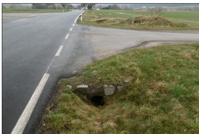
Propustek 65c - staničení 0,002 - pohled zprava
