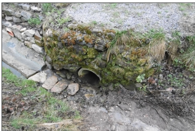
Propustek 54c - staničení 2,298 - pohled zleva
