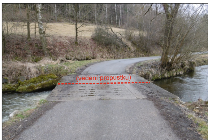
Propustek 65c - staničení 1,028 - celkový pohled
