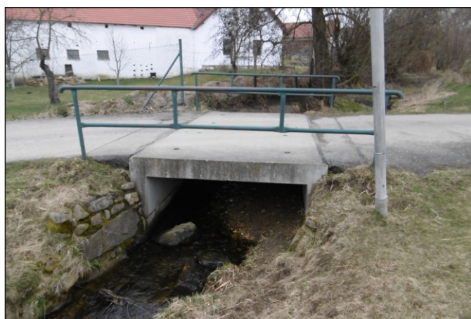
Propustek 55c - staničení 0,220 - pohled zprava
