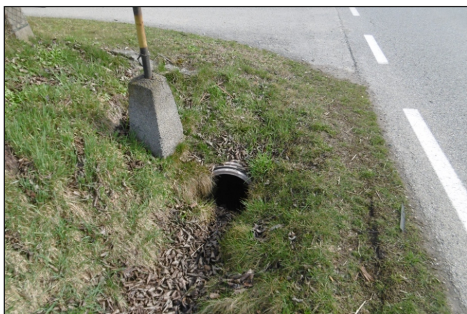
Propustek 82c (rameno) - staničení 0,050 - pohled zprava
