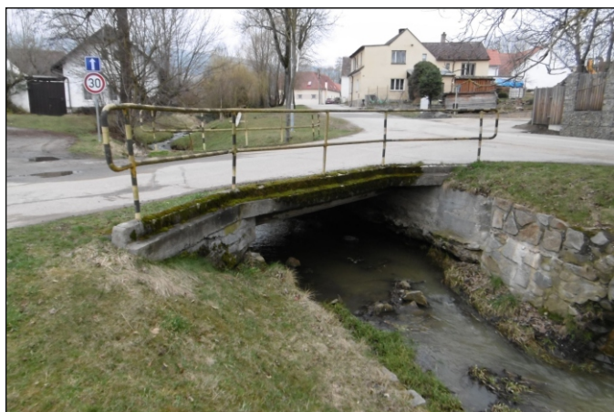
Most 46c-M1 - staničení 0,110 - pohled zprava
