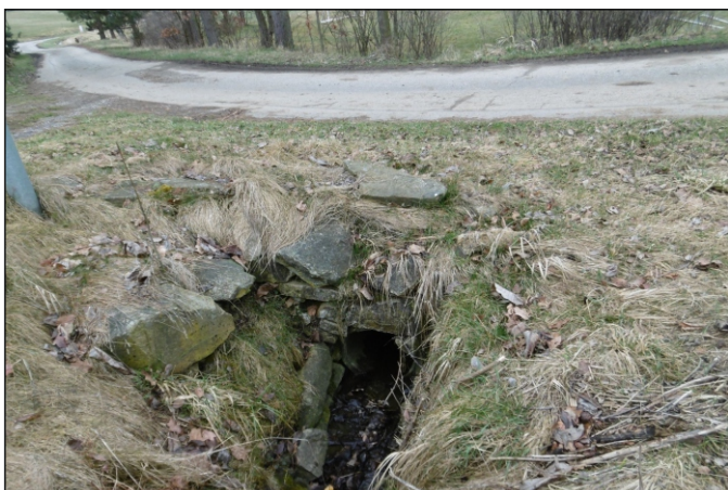
Propustek 79c - staničení 0,079 - pohled zprava
