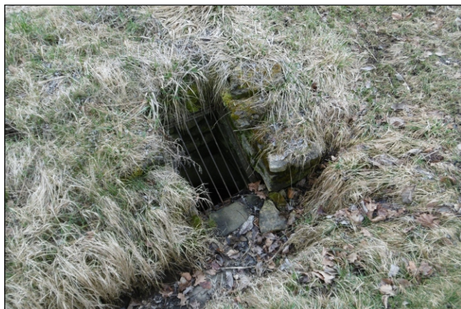
Propustek 79c - staničení 0,083 - pohled zprava
