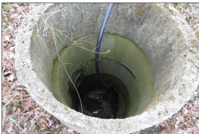
Propustek 80c - staničení 0,248 - pohled zleva
