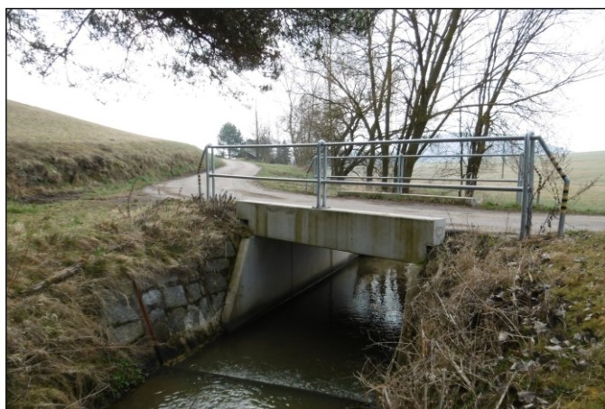
Most 75c-M1 - staničení 0,380 - pohled zprava
