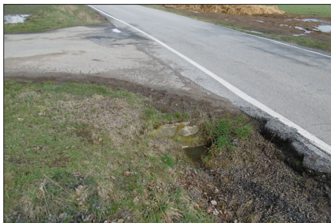
Propustek 23c - staničení 0,001 - pohled zleva
