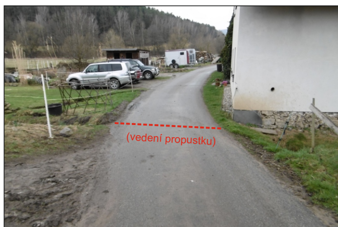
Propustek 65c - staničení 1,217 - celkový pohled
