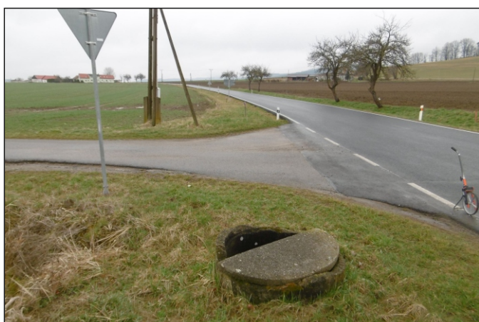
Propustek 65c - staničení 0,002 - pohled zleva
