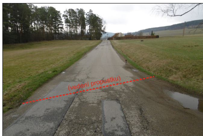
Propustek 44c - staničení 1,342 - celkový pohled
