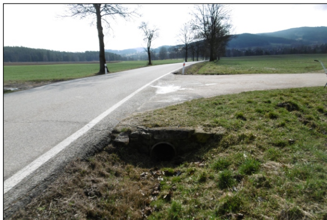
Propustek 23c - staničení 0,001 - pohled zprava
