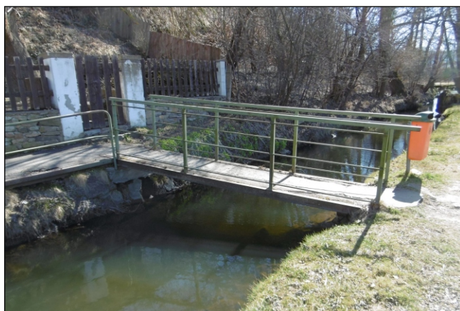
Lávka 44d-L2 - staničení 0,073 - pohled zleva
