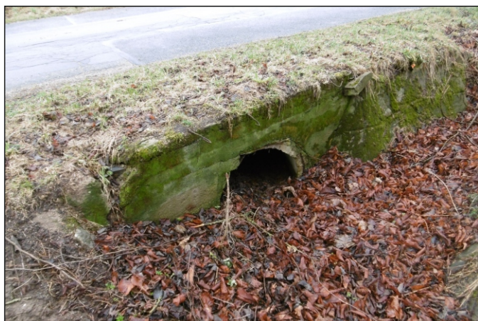
Propustek 54c - staničení 0,364 - pohled zprava
