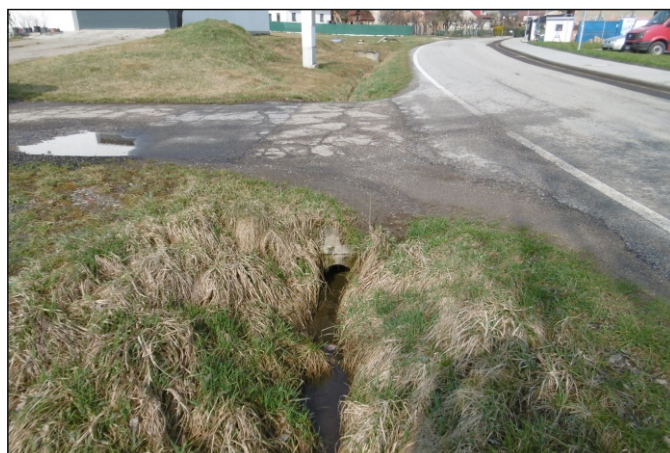
Propustek 22c - staničení 0,002 - pohled zleva
