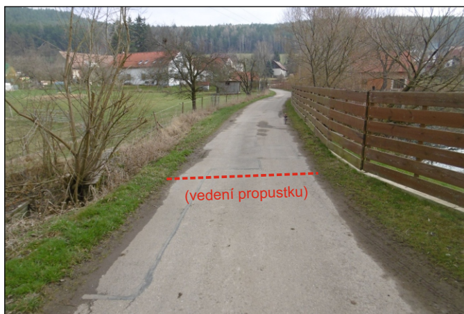
Propustek 80c - staničení 1,140 - celkový pohled
