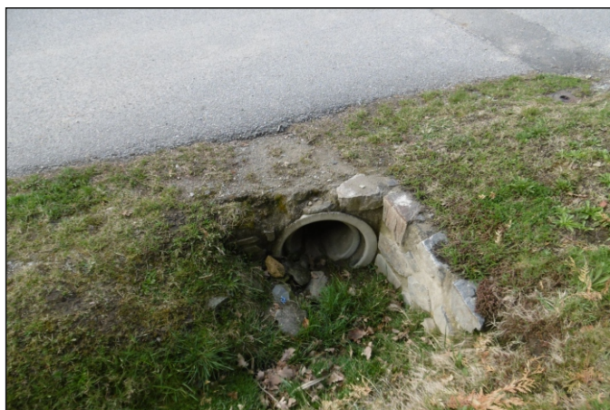
Propustek 87c - staničení 0,011 - pohled zleva
