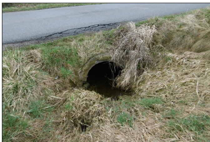
Propustek 65c - staničení 1,147 - pohled zleva
