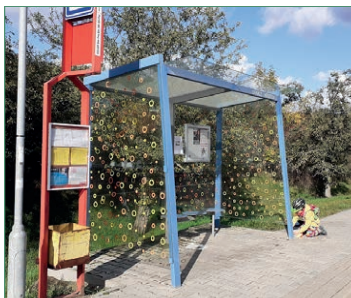
Takto vypadá efektivně zabezpečená zastávka. Nálepky jsou po celé ploše a zhruba 10 cm od sebe.
