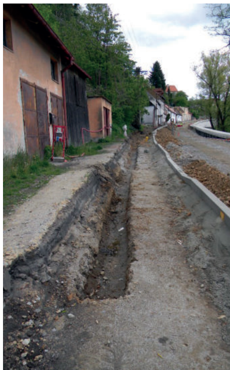
76. Obruba chodníku a rýha pro kabel
