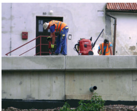
80. Vrtání otvorů do límce zdi
