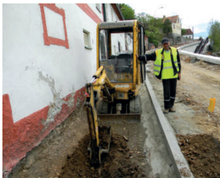
75. Příprava pro pokládku kabelu
