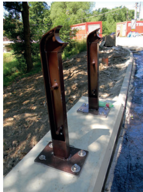
83. Montáž prvních stojanů svodidel
