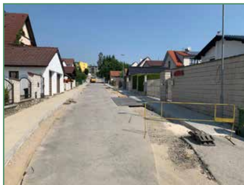
Rekonstrukce chodníků v ul. Nový Doubek.
