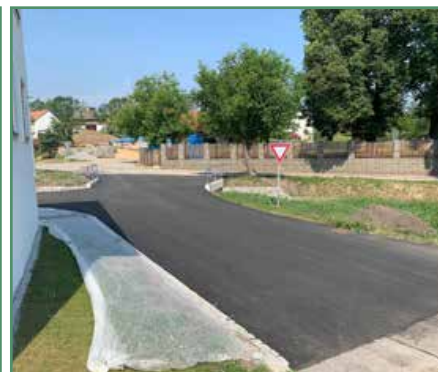
Rekonstrukce mostu v Chlumu je hotova.
